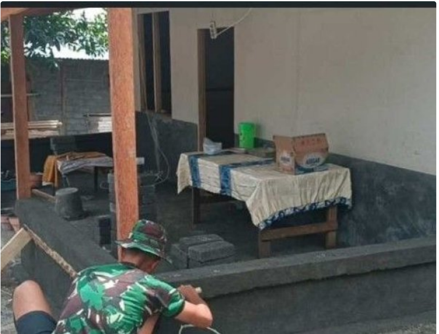
Satgas TMMD Kodim 1310 Bitung dalam Pekerjaan RTLH
