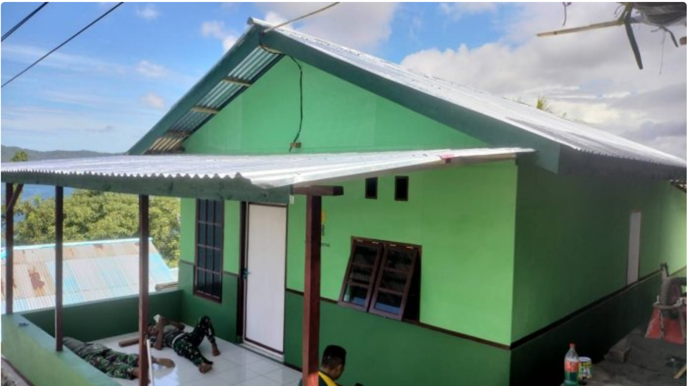
Renovasi RTLH TMMMD Ke-116 Kodim 1310 Bitung
